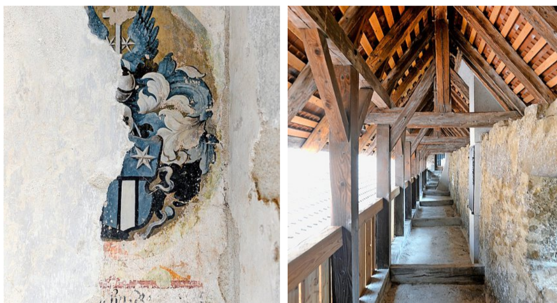
Tristan Gratier, Präsident der Fondation du Château, und Bettina Stefanini (oben). Im Schloss Grandson werden derzeit alte Fresken und Wehrgänge renoviert. Fotos: Michel Duperréx («La Région», Yverdon-les-Bains)
